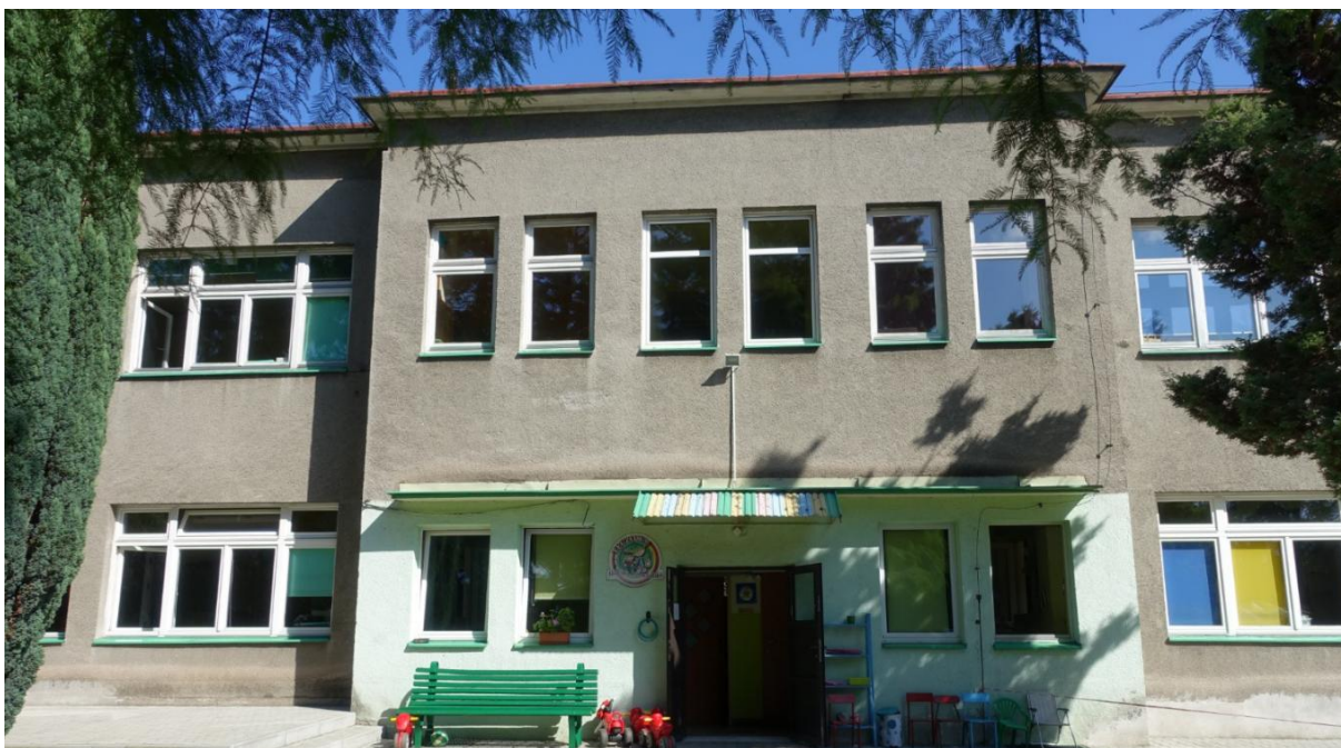
Fot.7. Elewacja południowa.
