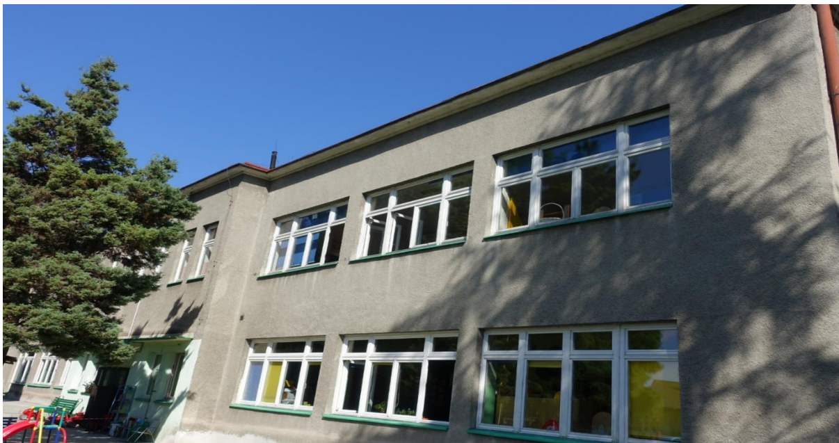
Fot. 6. Elewacja południowa. Brak możliwości zasiedlenia przez gatunki chronione.
