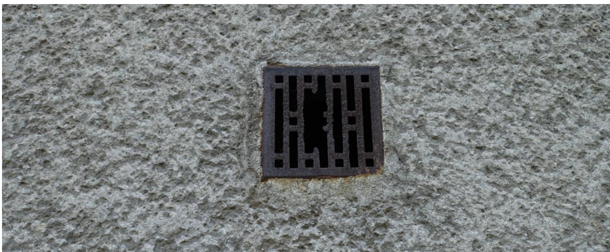
Fot. 4. Widok zabezpieczonego otworu wentylacyjnego.
