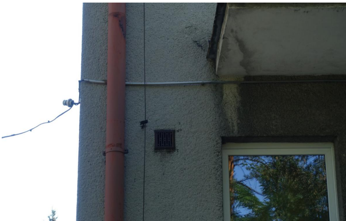
Fot. 10. Elewacja zachodnia-zabezpieczony otwór wentylacyjny.
