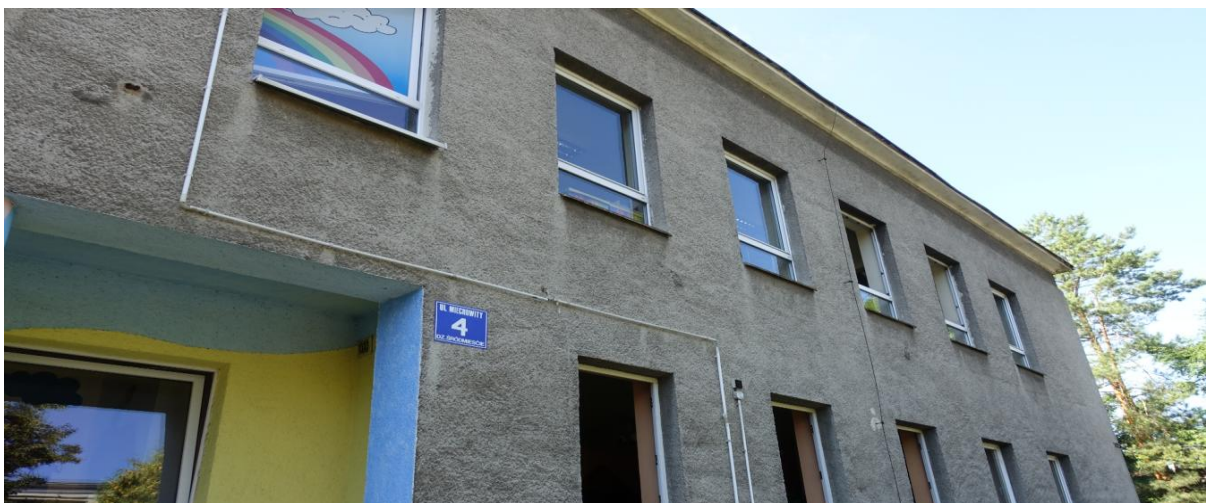
Fot. 3. Widok elewacji od strony wejścia do przedszkola.
