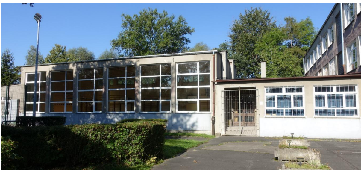
Fot.8. Elewacja wschodnia łącznika i sali gimnastycznej.
