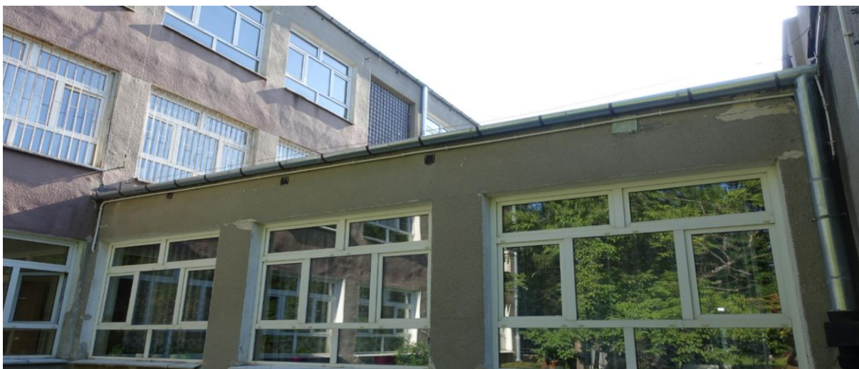
Fot.13. Elewacja zachodnia przełączki prowadzącej do sali gimnastycznej. Widoczne kratki wentylacyjne w otworach wentylacyjnych.
