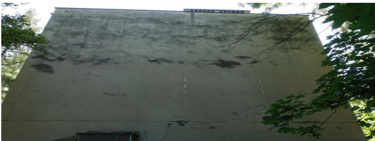
Fot.14. Elewacja zachodnia. Bez oznak zasiedlenia przez gatunki chronione.
