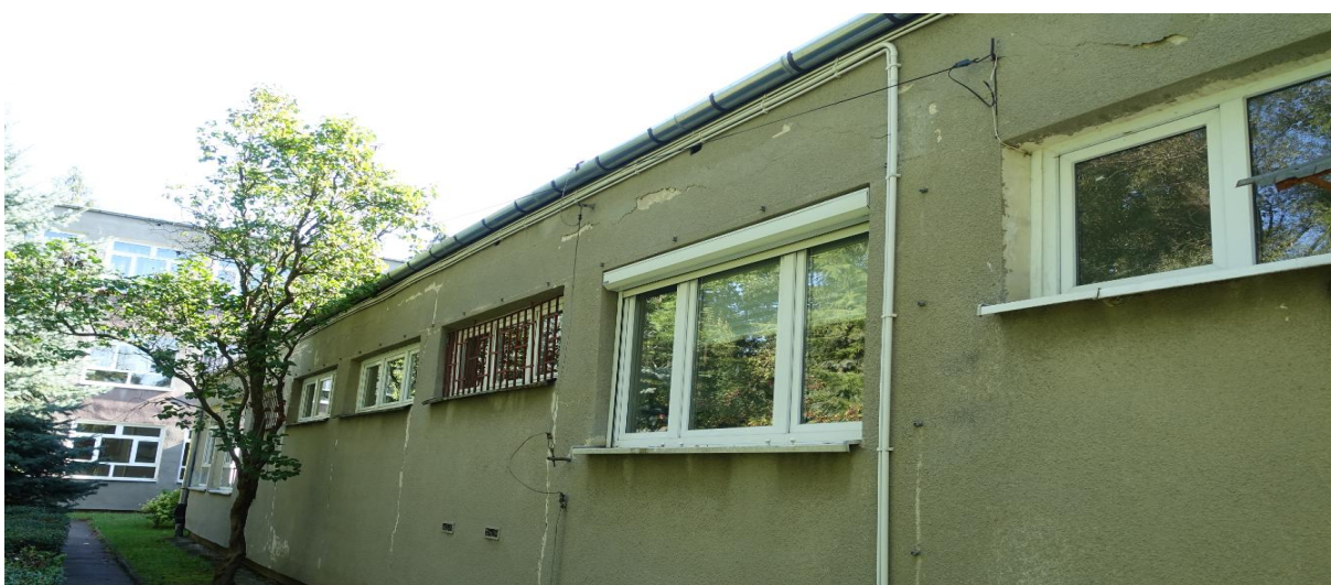
Fot.11. Elewacja zachodnia budynku sali gimnastycznej.
