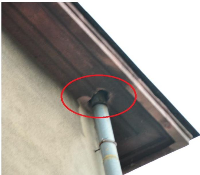
Fot. 11. Szczeliny przy wejściu rur spustowych do okapu stanowiące potencjalne siedlisko dla wróbli.
