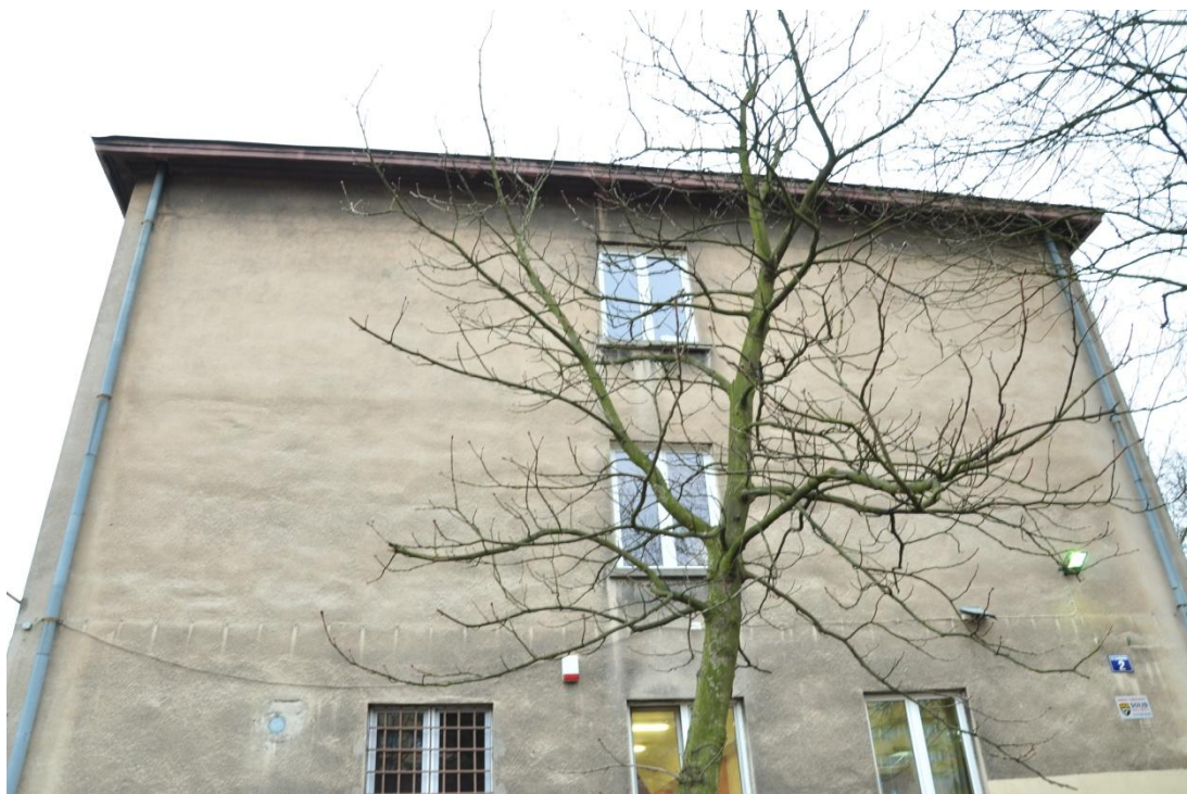
Fot. 9. Budynek główny szkoły – elewacja północna.
