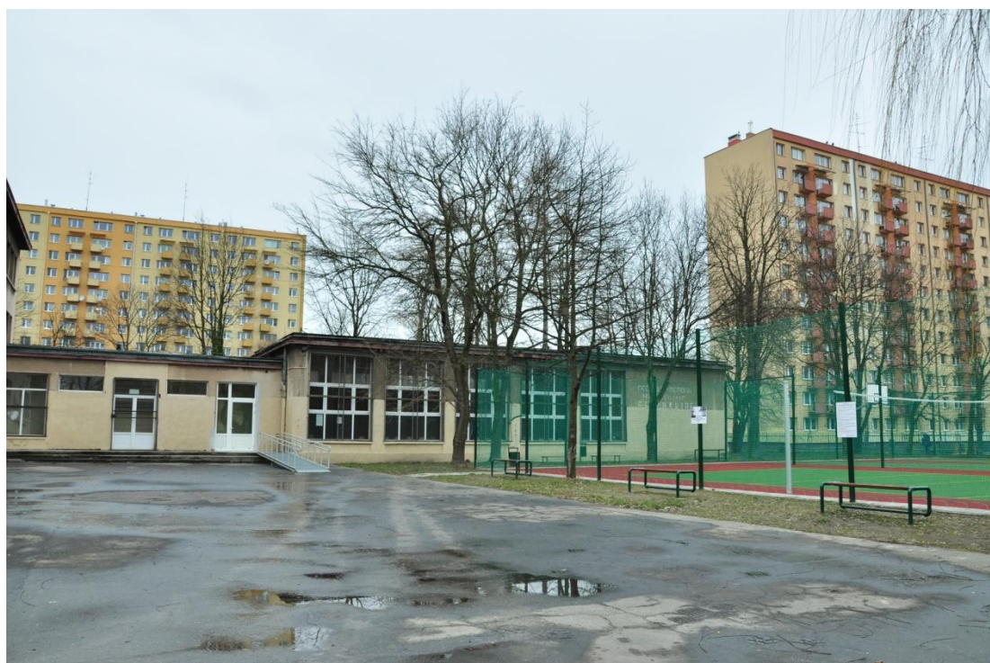
Fot. 5. Łącznik i hala sportowa – elewacja południowa.
