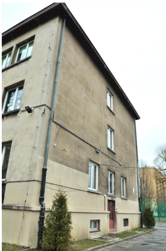
Fot. 3. Elewacja budynku głównego od strony południowej.
