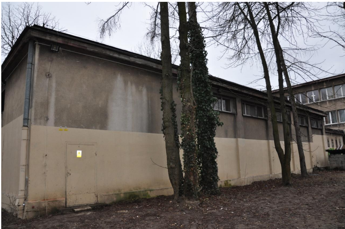
Fot. 7. Hala sportowa – elewacja północna.
