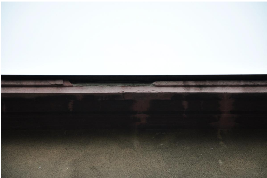
Fot. 12. Ubytki w gzymsie, mogące stanowić siedlisko dla wróbli.
