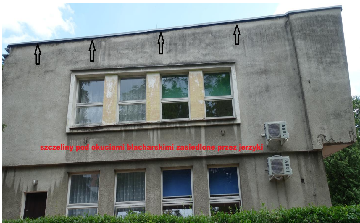
Fot. Nr 5. Elewacja wschodnia budynku Samorządowego Przedszkola nr 79 ul. Widok 23.
