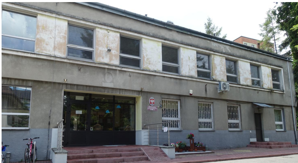
Fot. Nr 2. Część elewacji frontowej budynku Samorządowe Przedszkole nr 79 ul. Widok 23.
