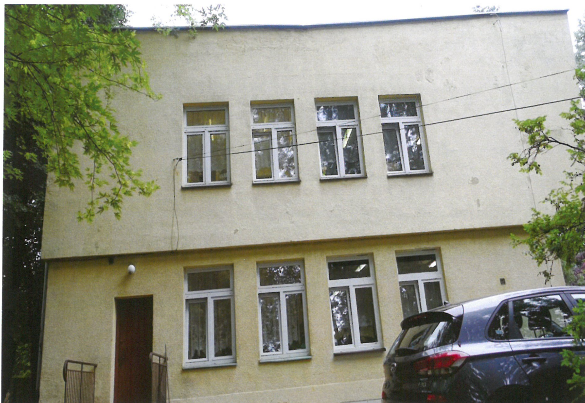
Fot. Nr 5. Elewacja zachodnia budynku Samorządowego Przedszkola nr 20 ul. Ułanów 38.
