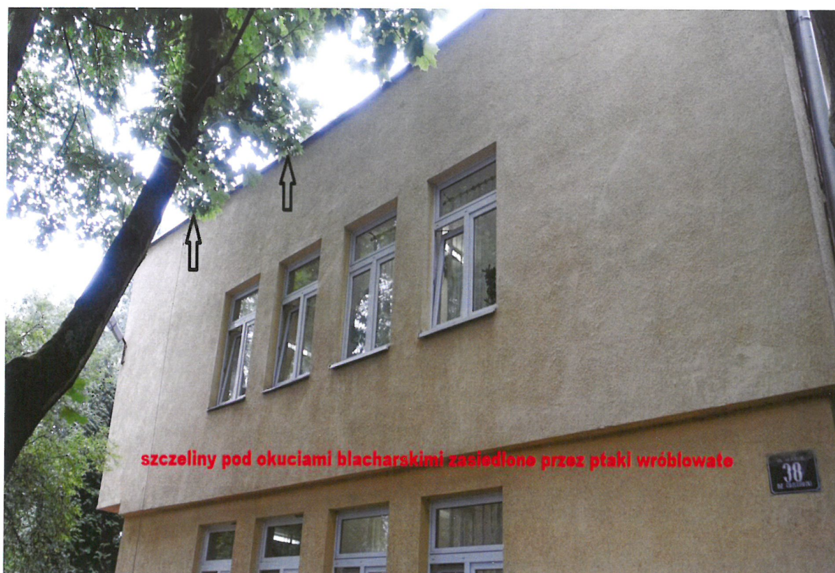
Fot. Nr 11. Elewacja wschodnia budynku Samorządowego Przedszkola nr 20 ul. Ułanów 38. Widoczne szczeliny pod okuciami blacharskimi to siedlisko ptaków z rzędu wróblowate.
